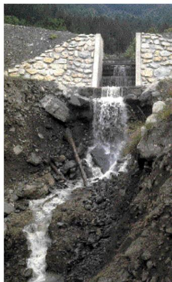
Le nant Croex, en Savoie ; vue de la plage de dépôt avant et après fonctionnement. À l'aval, la rétention des matériaux dans la plage a provoqué une forte incision du lit du torrent.
