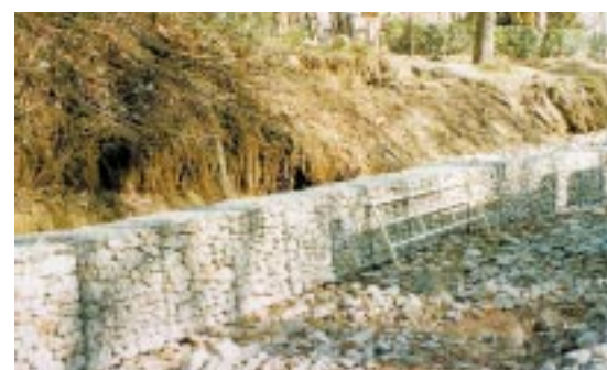
Mise en œuvre d'un rang de gabions sur la Lez à Montpellier.
