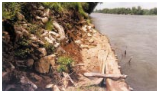
Confortement de berges sur la Loire à Couargues, à partir d'une protection de pied par fascines et d'un remblayage de la loupe d'affaïssement. Cette technique, très sensible vis-à-vis des contraintes d'immersion, aurait pu être avantageusement remplacée par la mise en œuvre d'une technique mixte similaire à celle proposée page 58.
