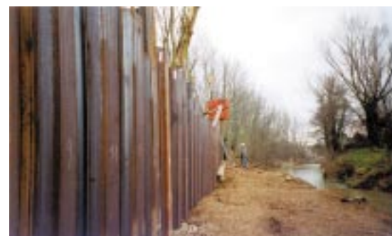
Mise en œuvre de palplanches de protection sur les berges de la Lèze à Labarthe-sur-Lèze.
