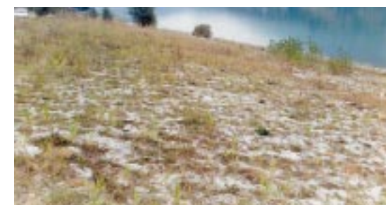
Développement après deux ans de marnage (avril 1997). L'aspect inesthétique de la natte est toujours observable.
