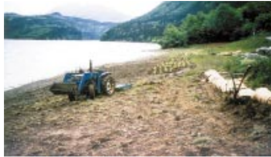
Mécanisation de la végétalisation permanente lors de la plantation des berges de la retenue de Monteynard en Isère.
