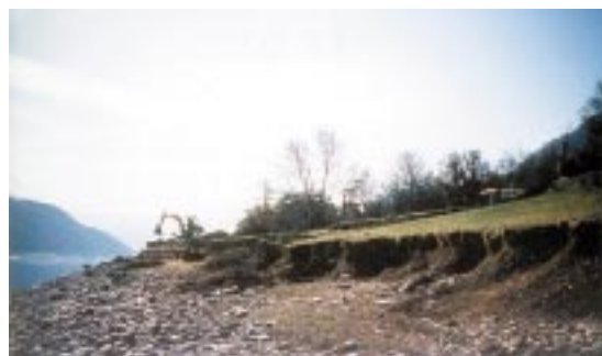
Erosion régressive de haut de berges, sur la retenue de Monteynard, provoquant une extension de la zone de marnage par décapage du sol en place.
