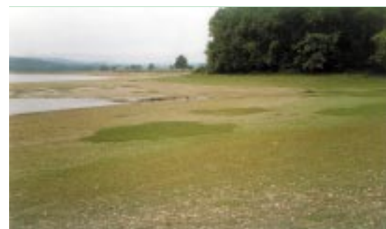
Une retenue en voie de colonisation (retenue de Puydarrieux dix ans après sa première année de mise en eau) : apparition de plaques d'espèces pérennes adaptées au marnage parmi un couvert végétal de type annuel.
