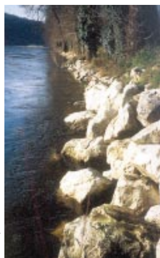
Berge enrochée de la Dordogne au niveau de la ville de Souillac.
