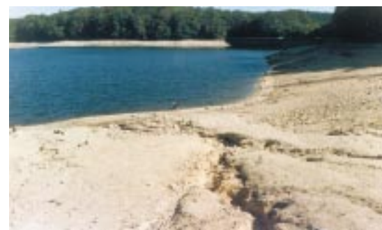
Berge sableuse sur la retenue du Lampy présentant de nombreuses ravines creusées par les eaux de ruissellement.
