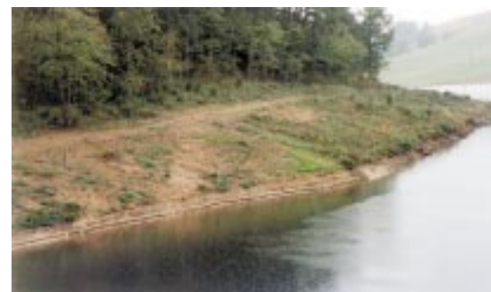
Site A2 : les trois parcelles traitées par ensemencement forment des taches vert tendre déjà bien visibles.
