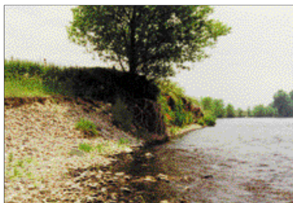
Une zone fortement abaissée par suite des extractions en lit mineur et majeur, avec drainage de la nappe et déconnexion des milieux alluviaux.
