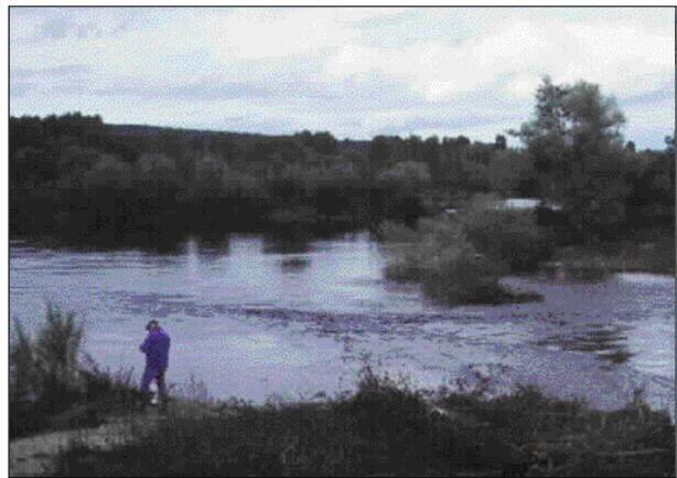
Une brèche créée par la crue dans le cordon d'enrochement isolant la gravière (ex. : Moselle, 1996).
