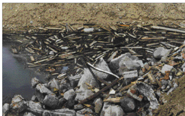
Les remblais et digues devraient toujours être construits avec des matériaux d'excellente qualité, présentant une bonne cohésion, et dénués de risque de pollution.
